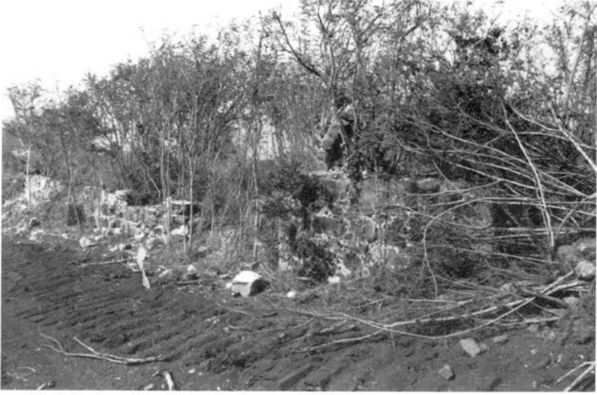
Fig. 9. - Les bâtiments domestiques pendant le passage du bulldozer. A gauche : socle de la maison principale ; à droite : la citerne.
