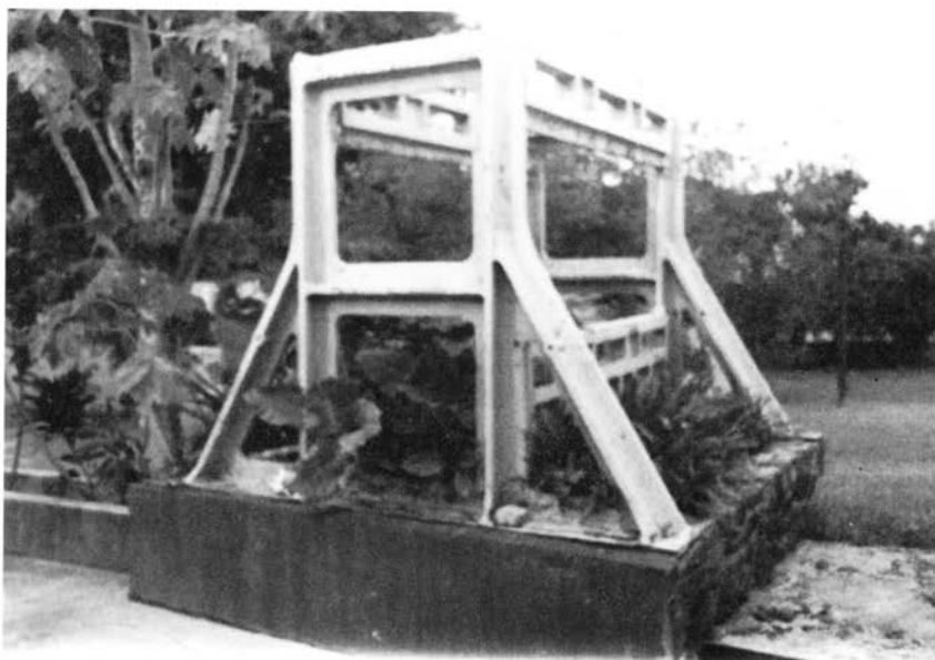
Fig. 20. – Châssis entièrement métallique (fonte), de fabrication anglaise. Habitation BELLE-PLAINE (Orléans).
