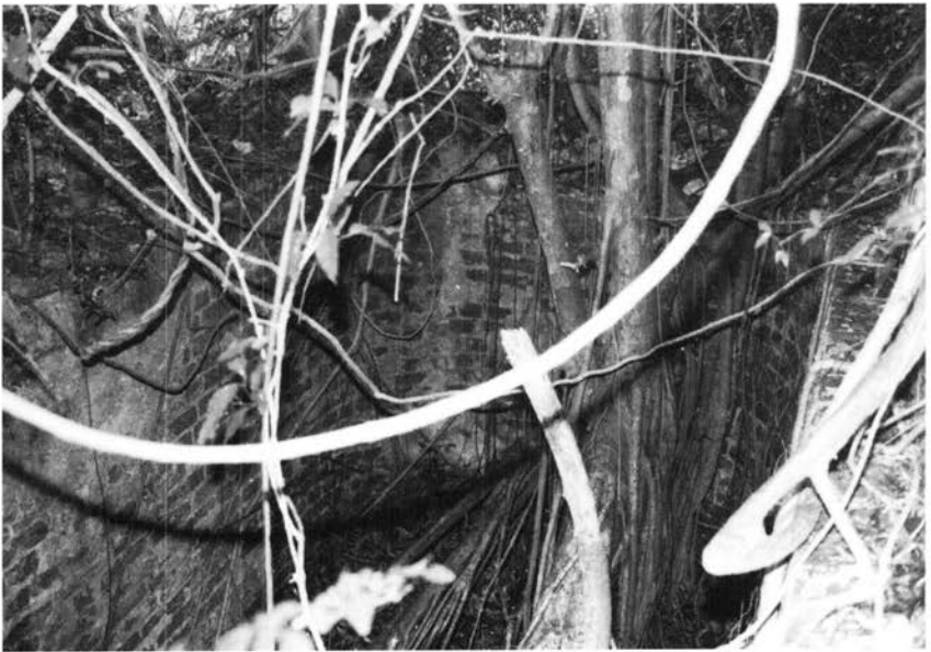
Fig. 8. - La citerne, doublée en briques, où refroidissait la « couleuvre » (ou serpent).
