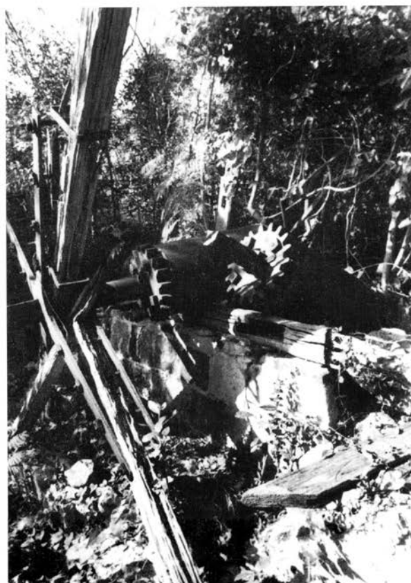
Fig. 2. – Moulin à bêtes vu de l'extérieur. En bas : le muret de soutènement de l'ancien moulin à un niveau. Au-dessus, ajouté postérieurement : le 2 e niveau excentré.
