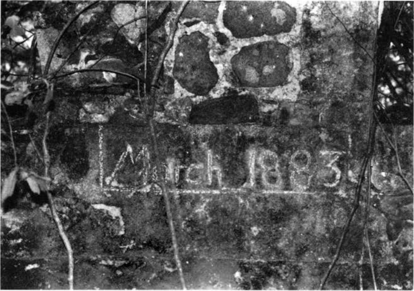
Fig. 4. - Date : mars 1883, gravée au-dessus des chaudières.
