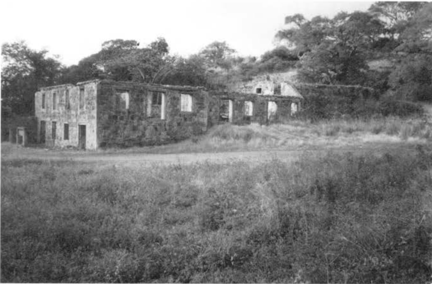
Fig. 10. - Les bâtiments industriels.
