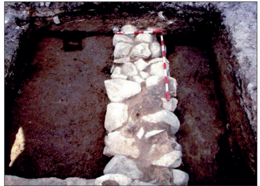
Figure 8. Les fondations d'une maison en bois du Régime français sous la rue Saint-Joseph à Pointe-aux-Trembles (ETHNOSCOOP 2015b, 40).
