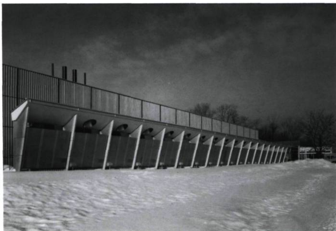
Pavillon de recherche à l'Institut Armand-Frappier (Laval), des architectes Tétrault, Parent, Languedoc et Dupuis Dubuc et associés. Tenu à la confidentialité de son contenu, ce pavillon se voyait grevé d'une contrainte programmatique désastreuse: l'interdiction de fenêtres. Contournant la contrainte, avec l'appui de l'Institut, on a créé un double voile d'acier perforé dans lequel la lumière joue au rythme des heures et des saisons.
