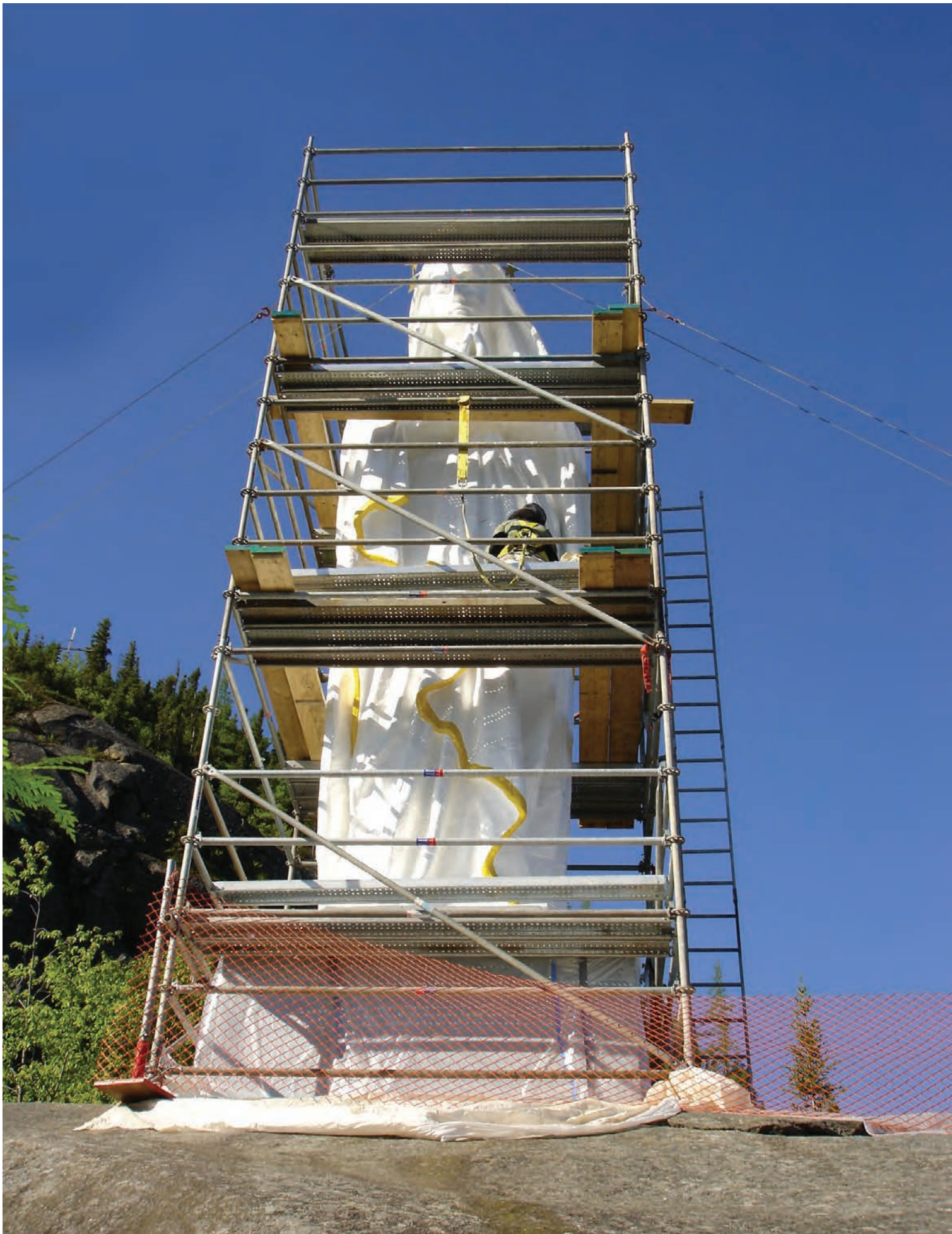
Louis JOBIN, La Madone du Saguenay , 1881. Une vue générale de la statue en cours de traitement avec l'échafaudage à quatre paliers donnant aux restaurateurs accès à toute la surface./An overall view of work on the statue with four-storey scaffolding to give the restorers complete access. Photo: Antoine PELLETIER © CCQ.
