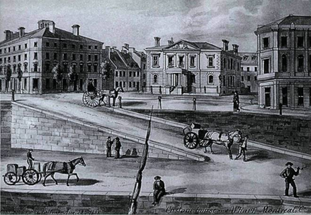
La nouvelle Douane et l'espace libéré par la démolition des bâtiments du côté du port. Source : Archives nationales du Canada C-13426
