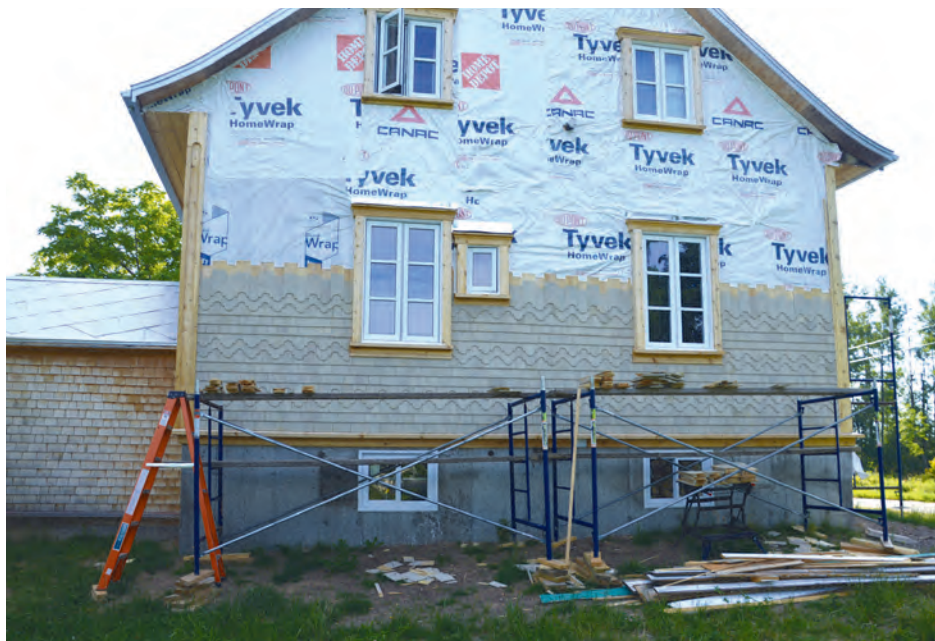
Un revêtement mural en bardeaux de bois peut durer plus de 150 ans ! Pour éviter que sa base se dégrade, il faut le poser à 0,6 m du sol et le protéger à l'aide d'un rejeteau.
