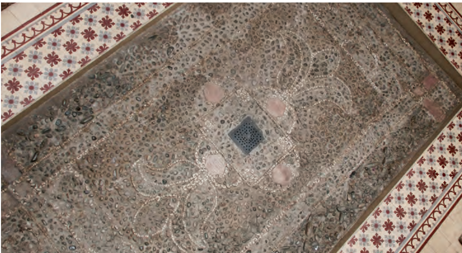
Ce plancher de patio couvert de galets de rivière arbore des insertions d'os de vache polis, vestiges d'une tradition hispanique.
