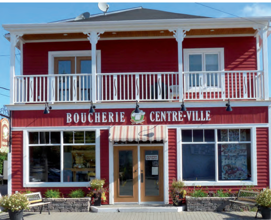
À Trois-Pistoles, des bâtiments situés au cœur de la municipalité ont été restaurés au cours des dernières années, notamment la Boucherie Centre-Ville.
