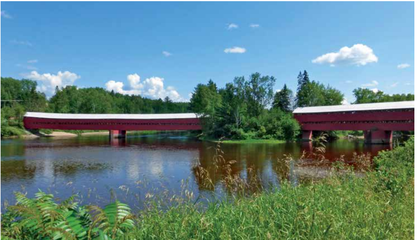
Les seuls ponts couverts jumelés du Québec, ceux de Ferme-Rouge, sont situés dans les municipalités de Kiamika et de Saint-Aimé-du-Lac-des-Îles.
