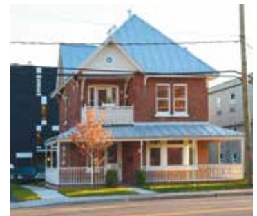
Maison Robitaille, avant et après sa restauration
