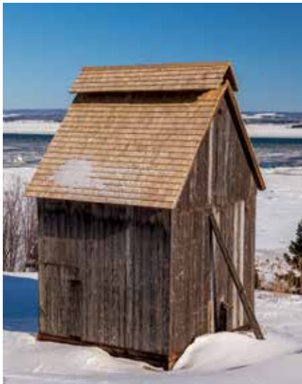
Fumoir de Martine Vally après sa restauration
