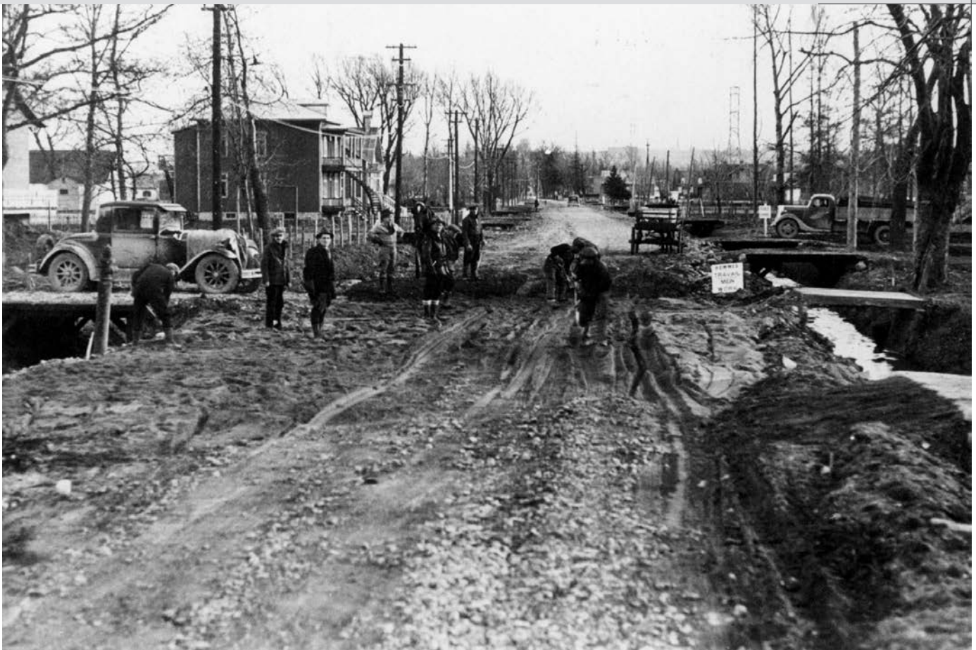
Route en construction, 1930-1939. (Archives du ministère des Transports du Québec).
