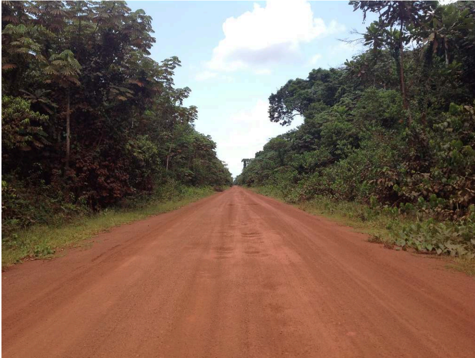
Figure 10. Route nationale numéro 4 / National Highway Number 4.
