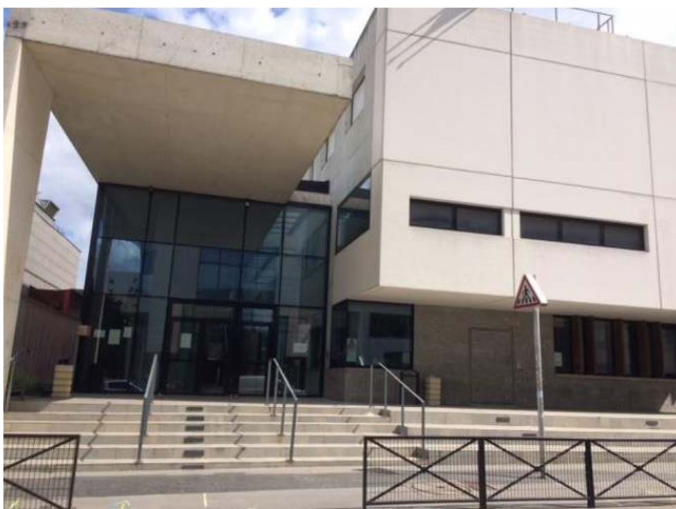
Figure 4. L'entrée de notre lycée : des marches d'escalier permettent d'accéder à un parvis couvert, puis au hall d'entrée, dont il est séparé par une façade entièrement vitrée.
