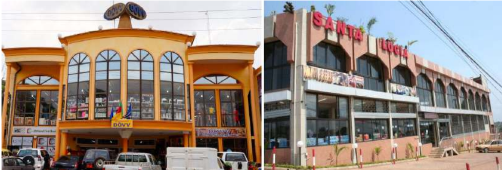
Figure 10. Vues des supermarchés DOVV au quartier Bastos et Santa Lucia au carrefour Mvan à Yaoundé.
