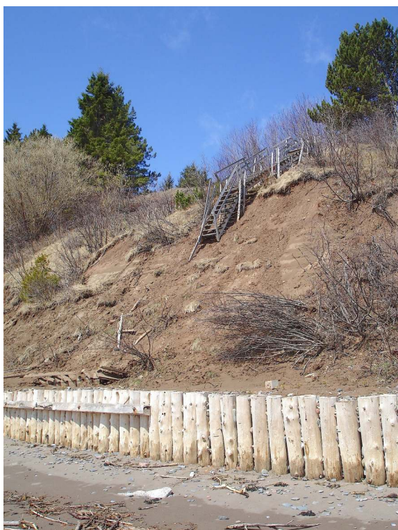
Figure 12. Effondrement d'un escalier d'accès à la plage à Carleton suite à l'érosion de la falaise.
