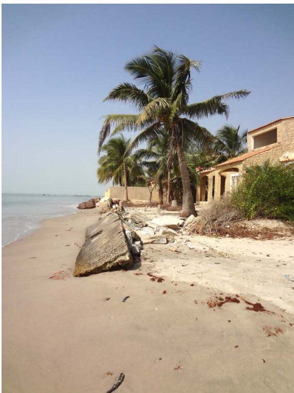
Figure 4. Une maison menacée à Joal.
