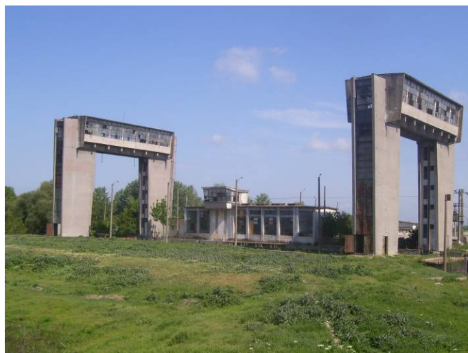
Figure 5. L'écluse de Pardina.
