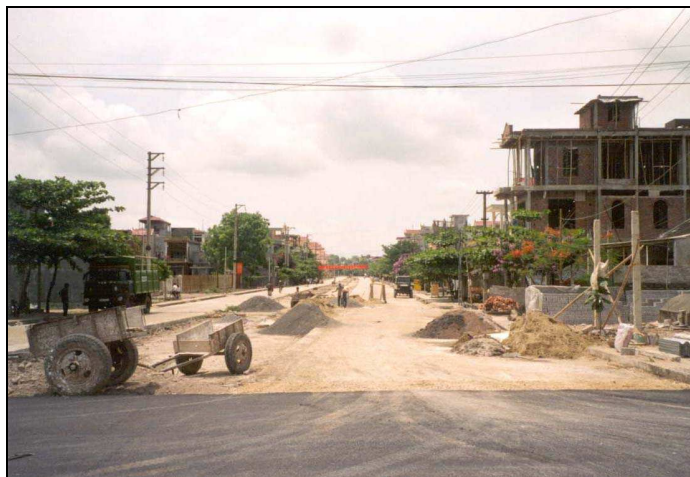
Figure 7 : Canalisation et enfouissement d'un canal anciennement voué à l'irrigation des rizières dans le quartier de Dong Thanh. Photo : Éric Mottet, 2002.
