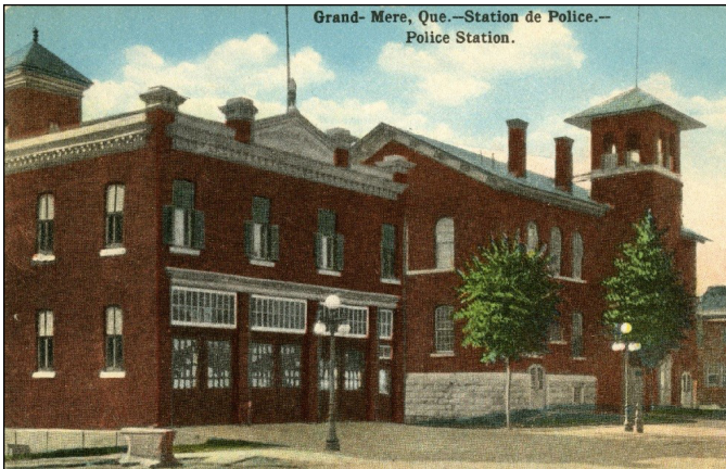
Figure 4. À gauche : La caserne de pompiers de Grand-Mère, Charles Lafond, 1913 et à droite, le marché public et salle du conseil, MacDuff et Lemieux, construit en 1902.
