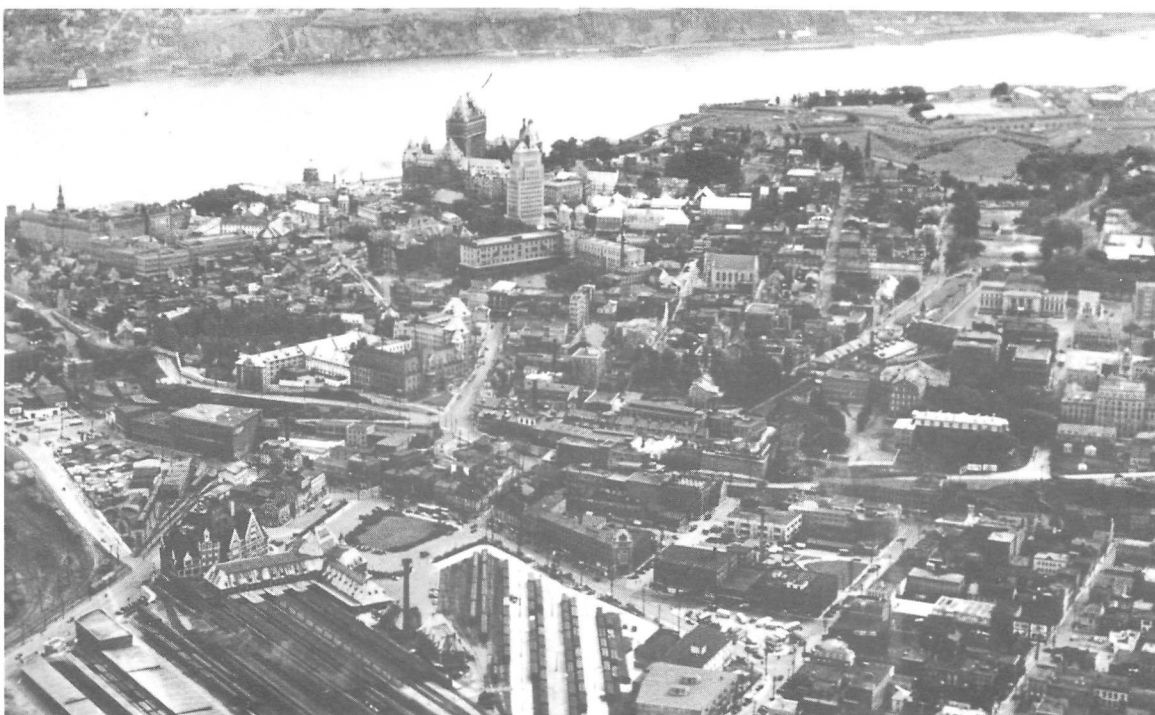
Photo aérienne de l'Arsenal de la Côte du Palais S.A. Photos de la ville de Québec, Québec, Commissariat à l'industrie, 1946, AVQ Sous-Série du Commissariat à l'industrie NB: 474/035
