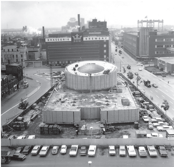
Figure 1. Construction du Planétarium Dow de Montréal, en 1965. Dans le mur entourant le chantier, des fenêtres furent percées « pour les curieux ». Planétarium Rio Tinto Alcan/ Espace pour la vie.
