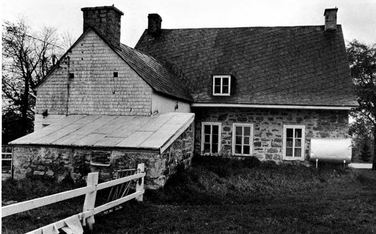
FIGURE 9. Maison C.-X. Larue, vue de l'arrière. La cuisine d'été en colombage à claire-voie et la dépense en maçonnerie. (Photo : Inventaire des Biens culturels )
