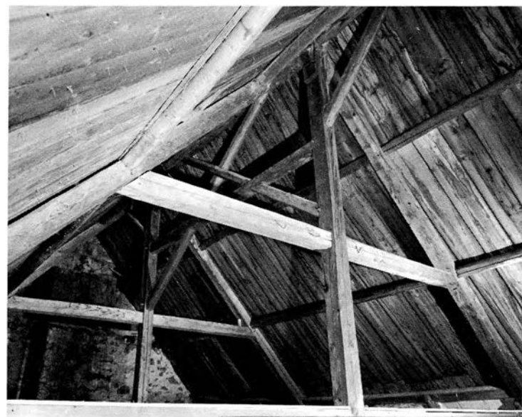
FIGURE 5. Maison Jobin, vue de la charpente. (Photo : Inventaire des Biens culturels )
