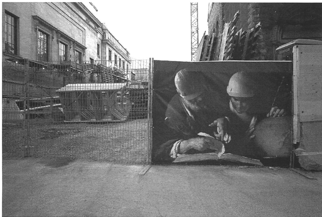
Chantier en cours, nouveau pavillon Claire et Marc Bourgie, nov. 2009
