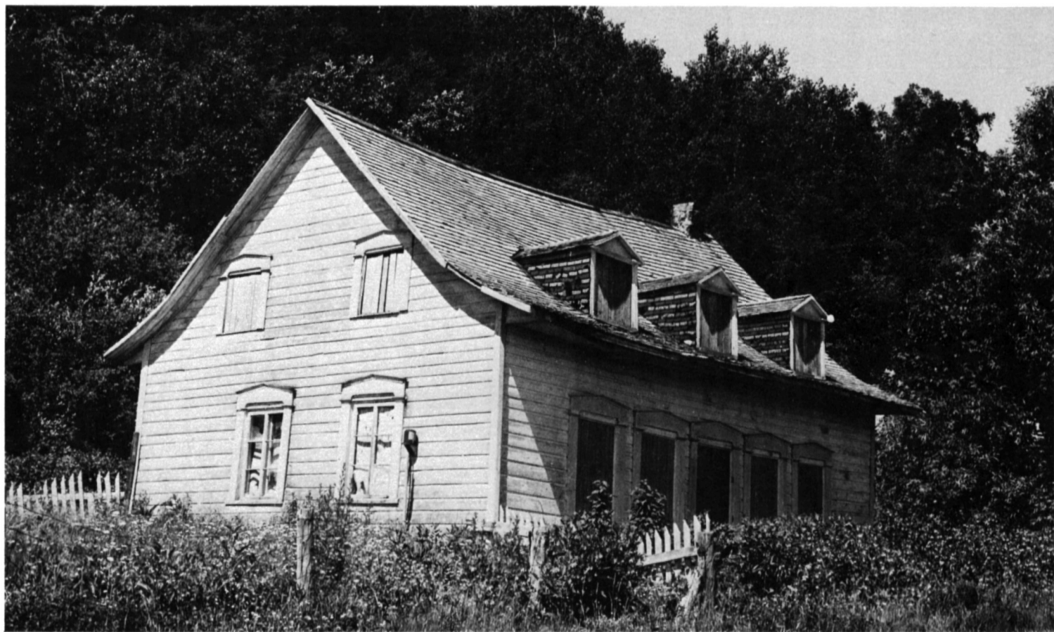
PHOTO 10 Photographie de la Maison Didier Leclerc. Photo R. Vézina.
