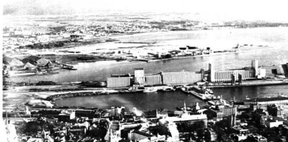
Photo 3 Du premier plan vers l'arrière-plan, on peut observer : — Le bassin Louise et les élévateurs à grain. — L'embouchure de la Saint-Charles où pénètrent les barges amenant le bois à l'usine de pâte à papier (à gauche sur la photo). — Les battures de Beauport et l'étirement vers l'est de la banlieue de Québec. — Au fond, le rebord des Laurentides.
