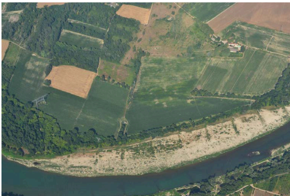
Figure 3. La partie amont de l'île de la Platière et les épis Girardon en rive gauche du Rhône
