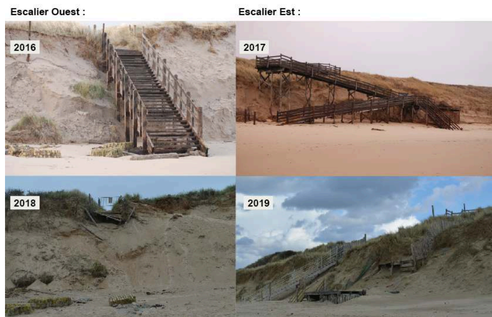
Figure 6. Les accès à la plage Est et Ouest, avant et après des événements tempétueux.
