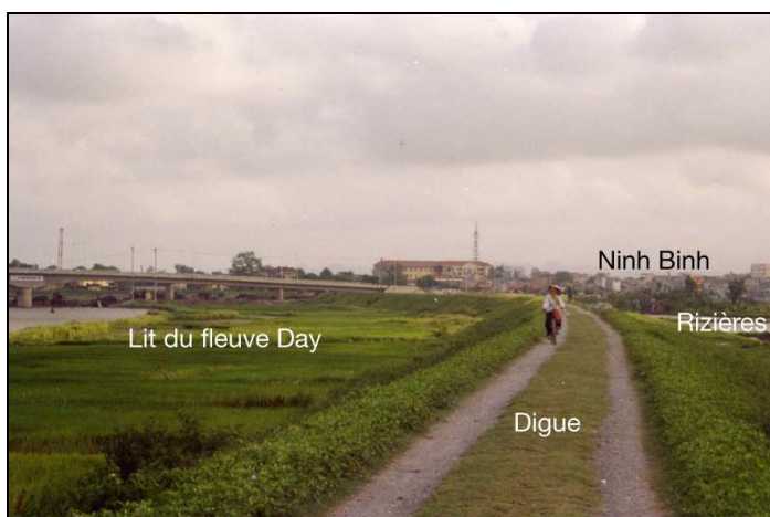
Figure 5. Les digues, système de protection et de communication. Leur hauteur fait qu'elles sont toujours surmontées d'une route ou d'un chemin, ce qui en fait un réseau de communications très efficace. Photo : Éric Mottet, 2002.
