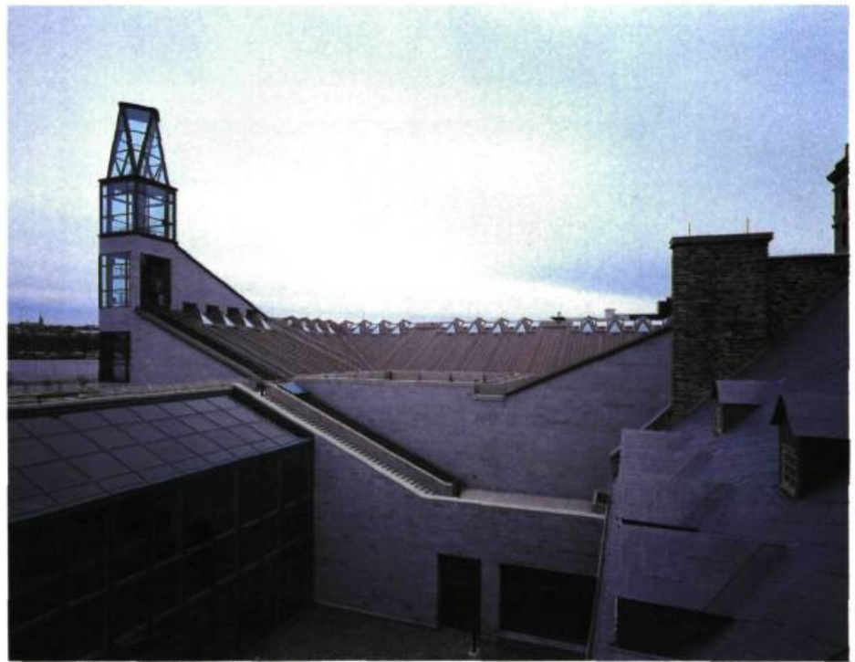
Cour intérieure, escalier d'accès aux terrasses supérieures, campanile. (Photo Pierre Soulard)
