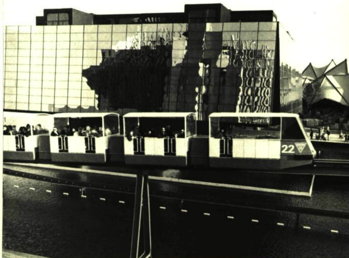
3 — Derrière le mirail, le pavillon du Québec s'élève sur quatre piliers reposant sur une plate-forme entourée d'eau; sur ses quatre faces en talus, des reflets ondulent. Les architectes sont: Papineau, Gérin-Lajoie, Leblanc & Durant. Au fond, à droite, le pavillon de l'Ontario présente sa toiture de toile tendue sur une structure rigide au-dessus d'énormes blocs de pierre en gradins. Fairfield & Dubois, architectes.
