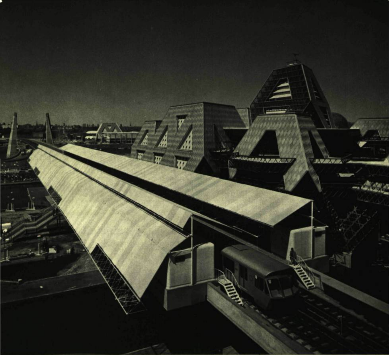
8 — Structures: la station de l'Île Notre-Dame. André Blouin, Beaulieu, Lambert, Tremblay architectes. Un simple voile tendu sur un réseau de fil de fer. Pavillons thématiques: tétraèdres tronqués construits au moyen d'une structure tridimensionnelle. Affleck, Desbarats, Dimakopoulos, Lebensold, Sise, architectes.
