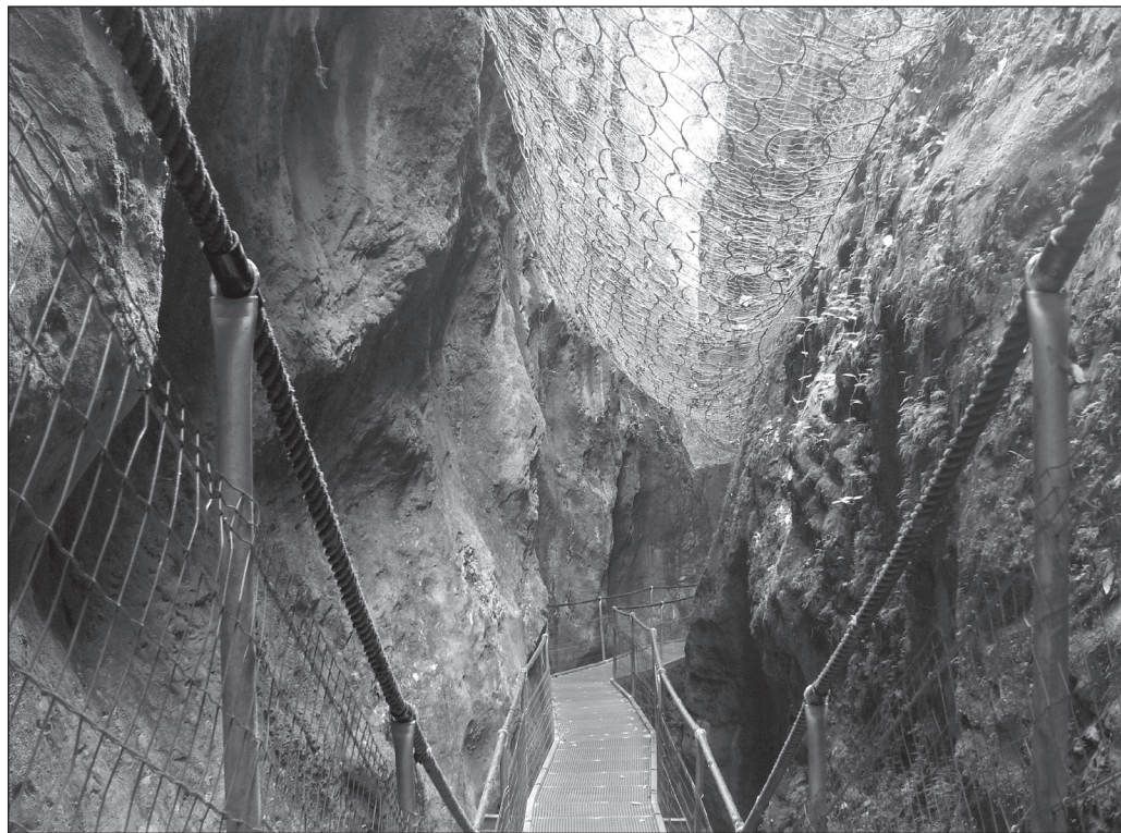
ILLUSTRATION 7 : Un aménagement lourd de l'espace (escalier, passerelle, filet-auvent métallique) (photo : André Suchet).
