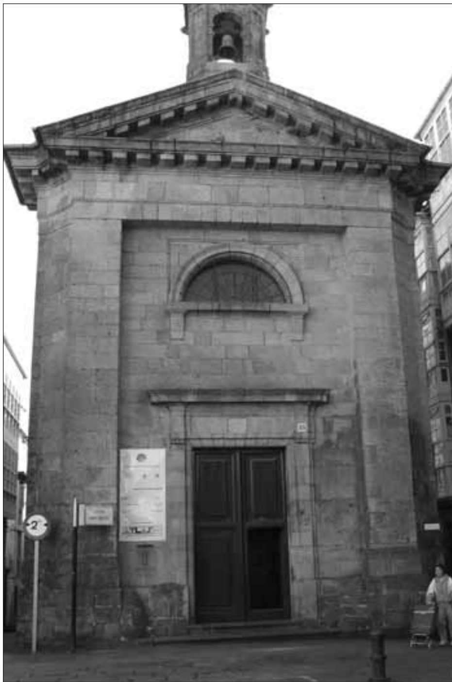
San Benito, en cours de réhabilitation.
