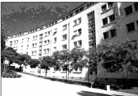
La « Banane », immeuble courbe construit en 1953, est l'un des plus caractéristiques de l'architecture lorientaise : volume simple — une barre courbe de 120 mètres — porte-à-faux et toitures-terrasses, contrastes de l'enduit blanc et des détails de couleurs vives. Jean-Baptiste Hourlier, architecte. Photo : P. Dieudonné.
