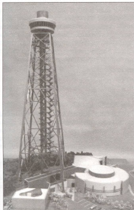
La tour et le Centre des sciences.
