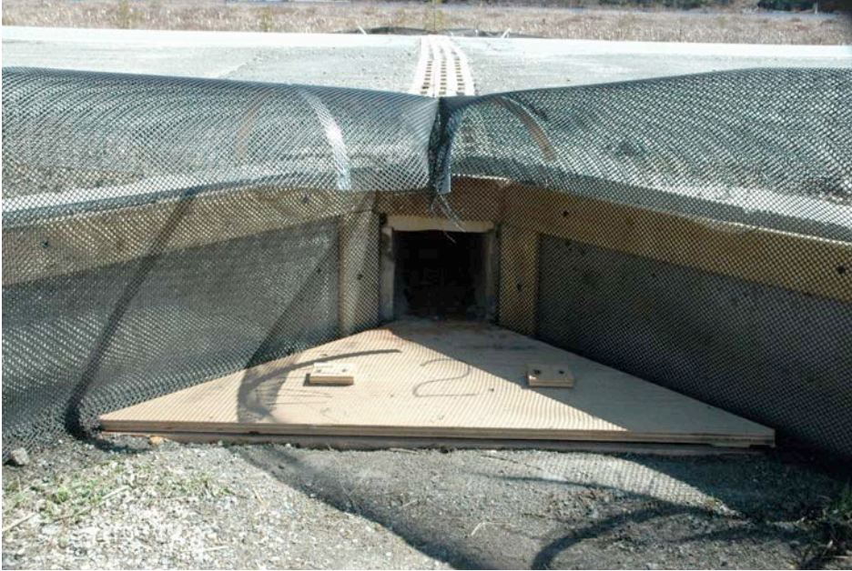
Figure 3. Entrée du tunnel permettant aux amphibiens de traverser la route 220 sans danger.
