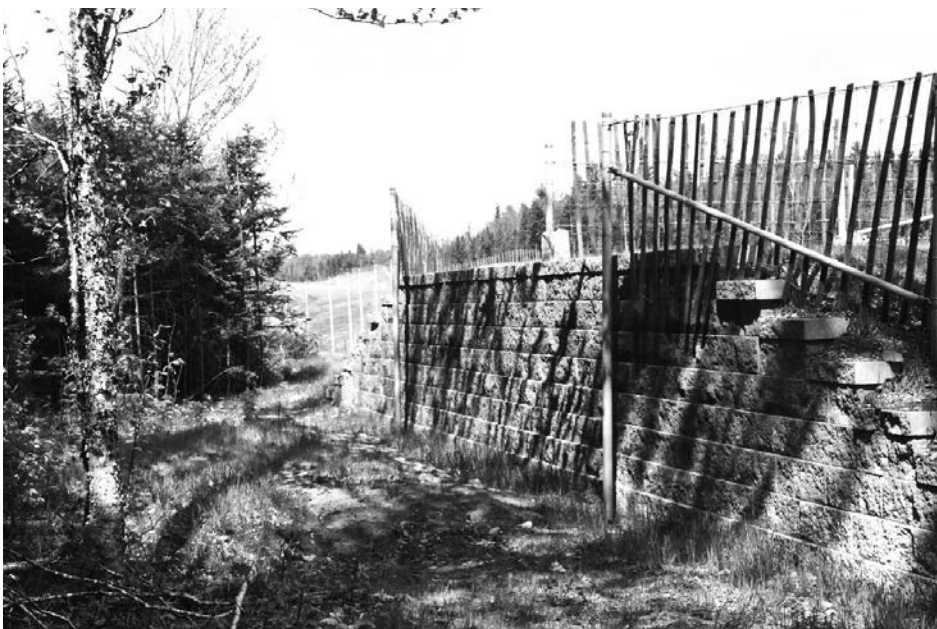
Figure 2. Un des 30 sautoirs installés dans le ravage de cerfs de Virginie de Calway dans le secteur du prolongement de l'autoroute Robert-Cliche (73), Saint-Joseph-de-Beauce, Québec. En haut: Vue de la pente douce du côté de l'autoroute. Ci-dessous: Vue du mur vertical du côté de la forêt.
