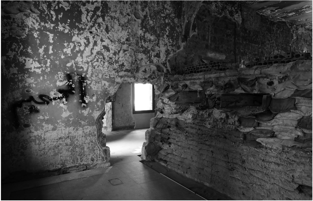
Beit Beyrouth: le bunker au 1 er étage © Youssef Haidar
