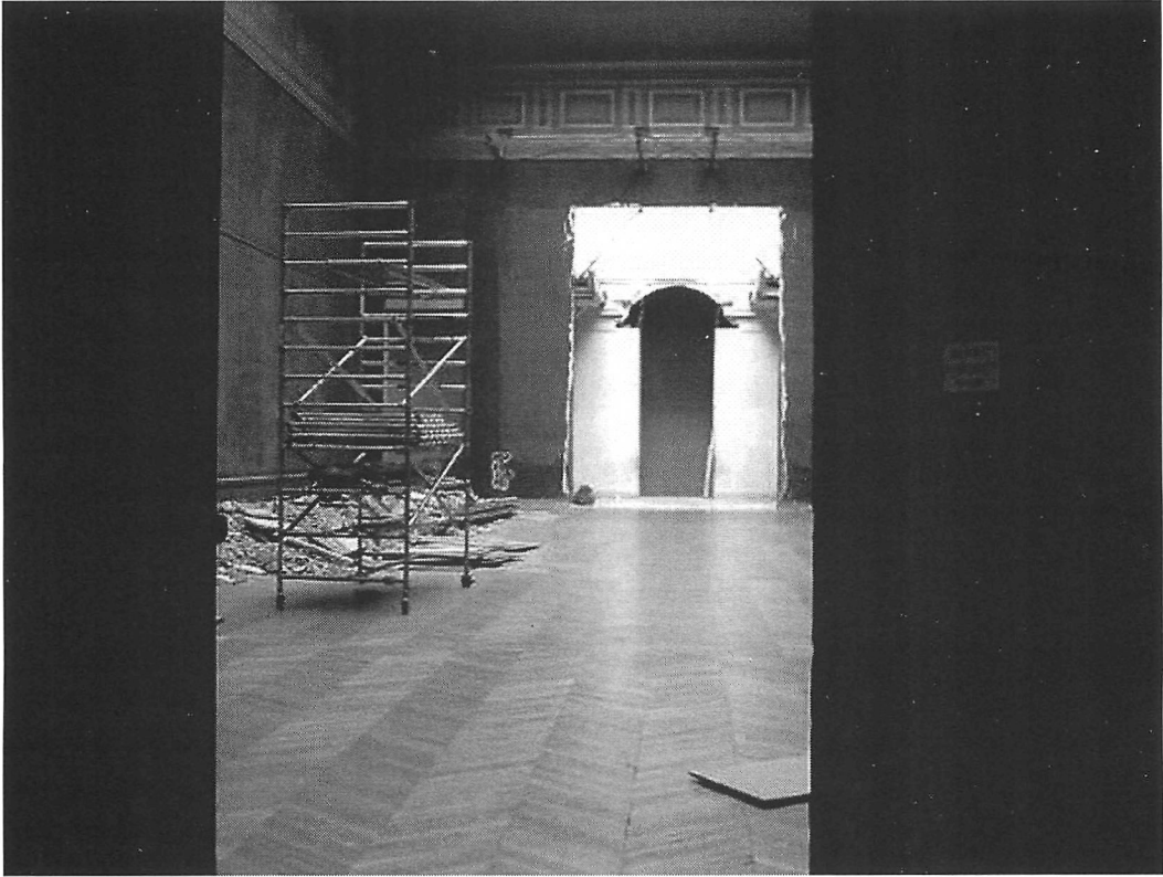
Illustration 5 Salle des États, situation des travaux en novembre 2002. Photographie : Fabien Bellat.
