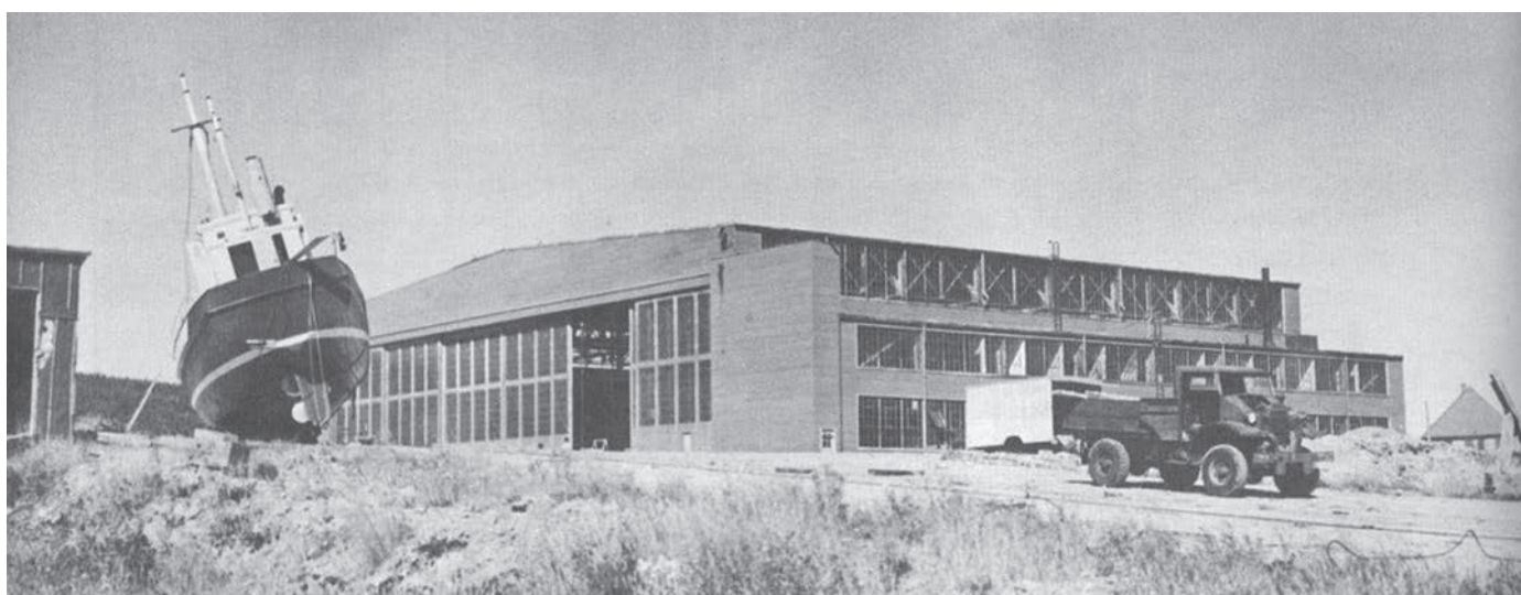
Le Chantier maritime de Gaspé et un chalutier en cours de lancement, 1955.
