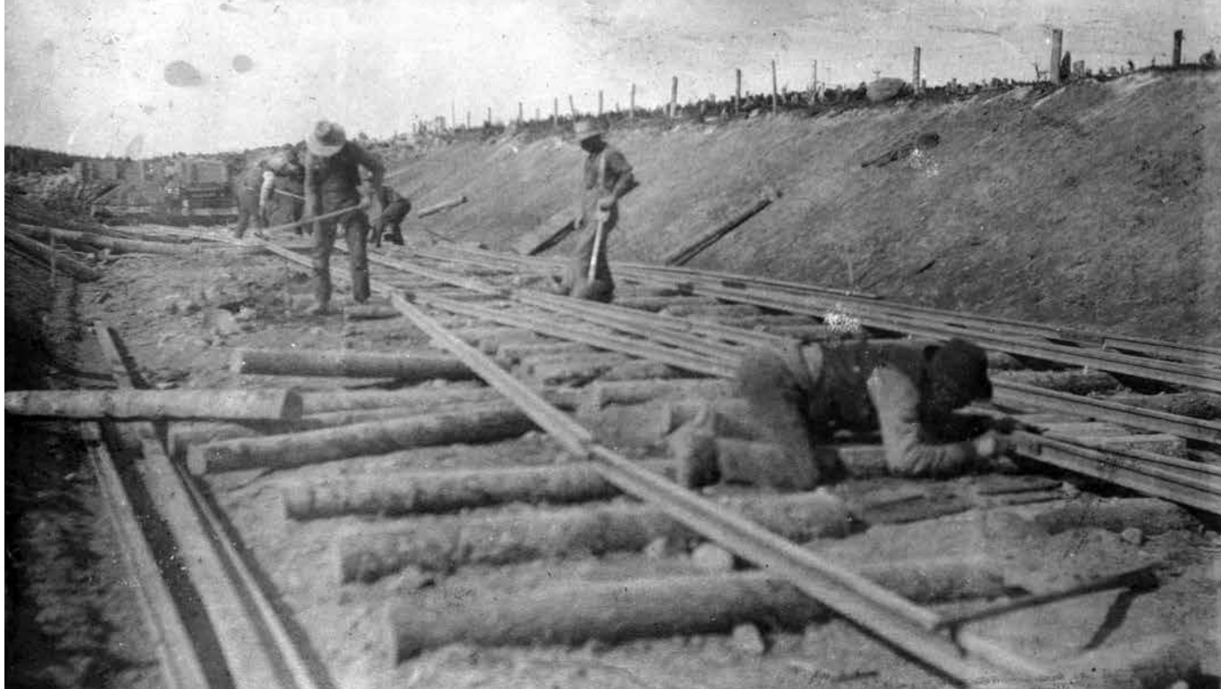
Les ouvriers s'affairent à poser des rails. Pour empêcher les accidents, on construisait une voie d'évitement. Dès lors, deux trains pouvaient se rencontrer sans problème. Septembre 1905.
