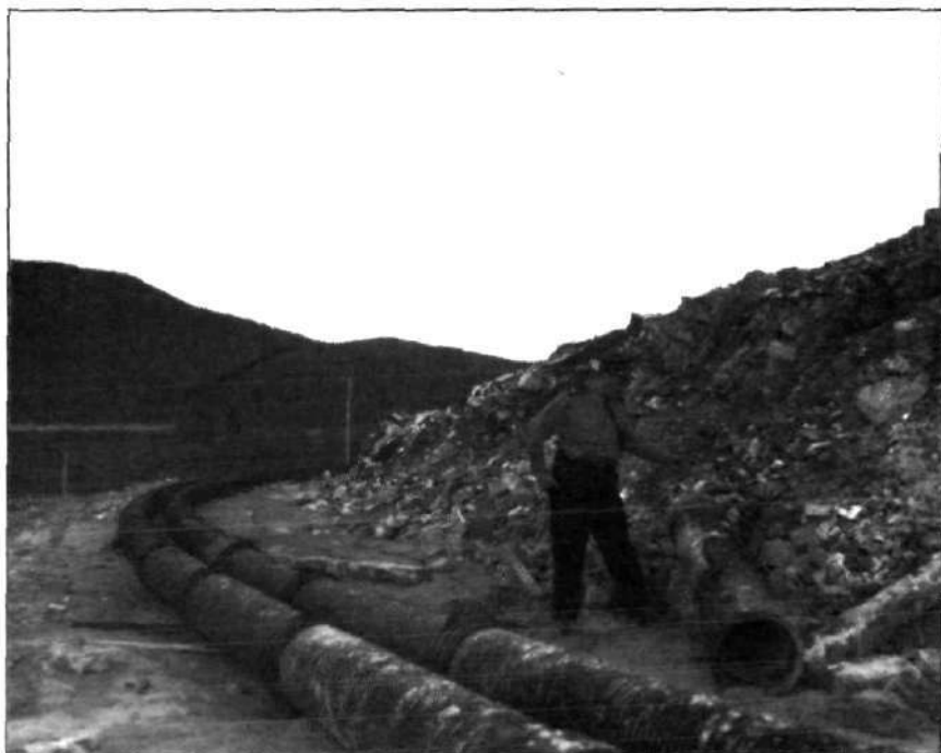
Le sergent René Marchand montre la section du tuyau de décharge dont le dynamitage a tué Bernatchez et blessé deux autres personnes. (Montreal Star, Archives publiques du Canada Photo PA 128055.)
