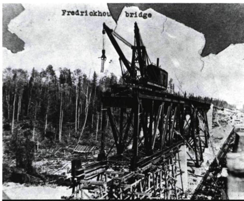
La construction d'un pont sur la Frédérickhouse pour le National Transcontinental, ca1912-1914 (Photo : CRCCF ; Ph56-3, Collection Northland Post, Cochrane)
