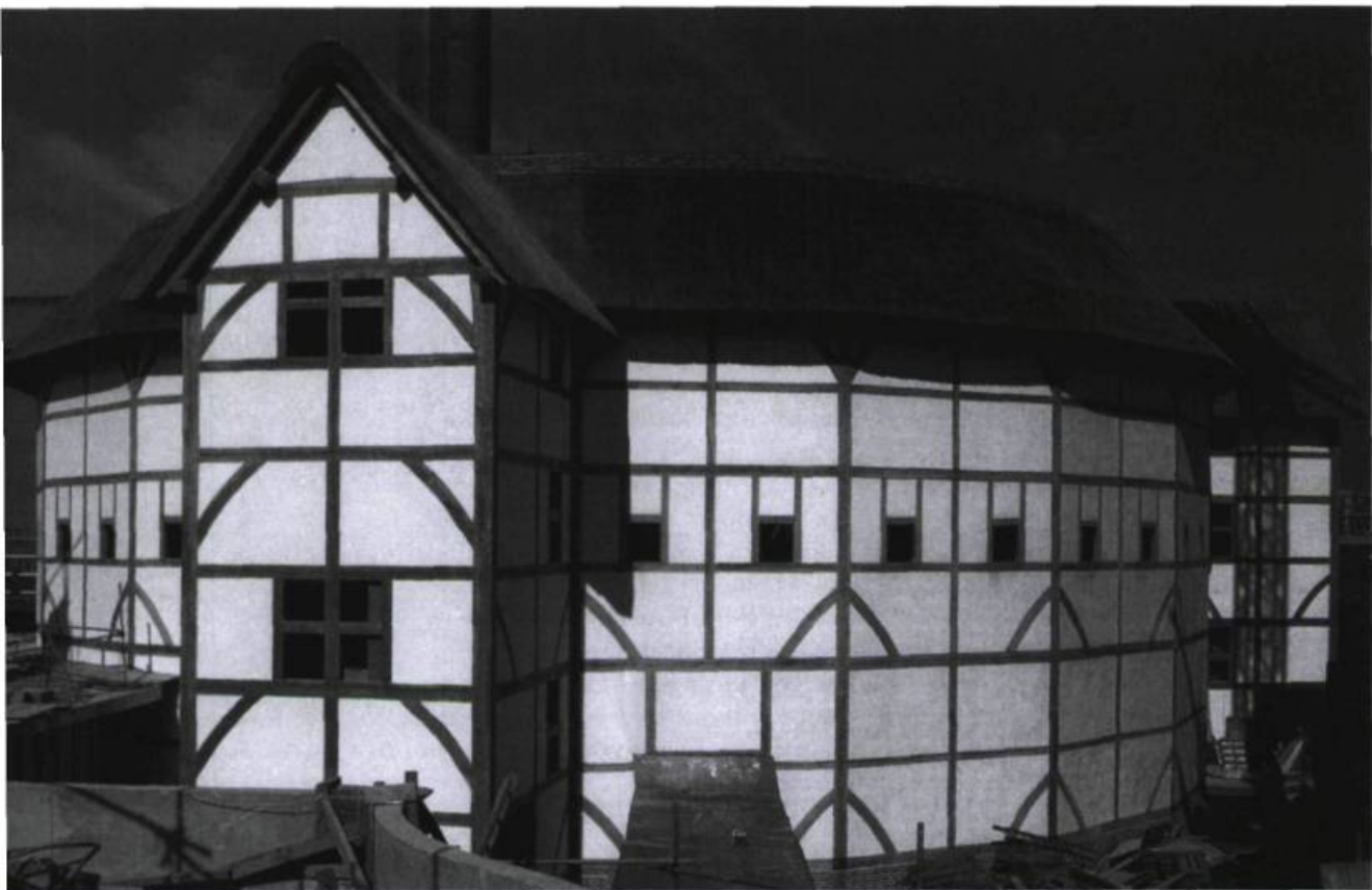
Le nouveau Globe, en fin de construction. Photo : Richard Kalina, tirée du catalogue-souvenir.
