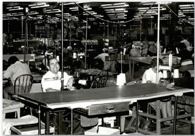
Rubin Bros., intérieur de l'usine. (Source : SHGV 05, fonds de La Nouvelle Union/Transcontinental, P37058[002])
