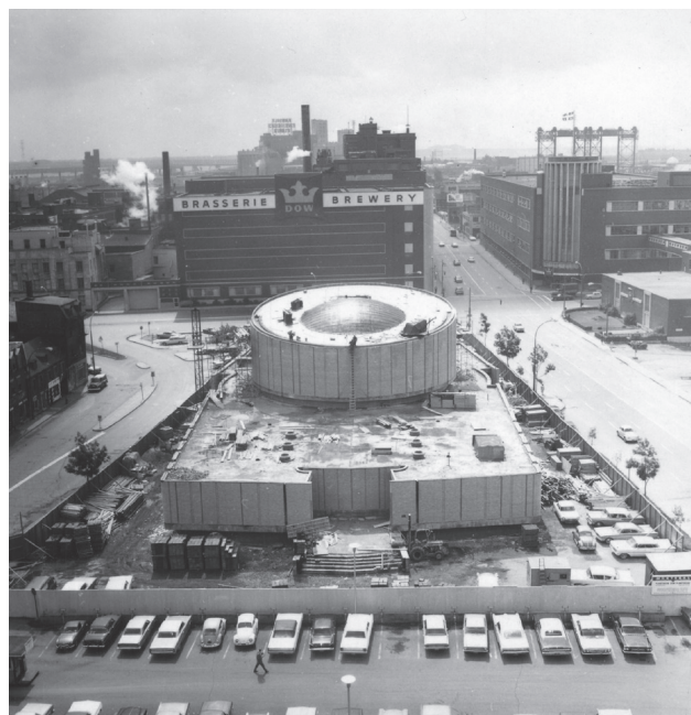
Le chantier du Planétarium Dow. – 1965. – Archives de la Ville de Montréal / Espace pour la vie (VM194-UI290-007).
