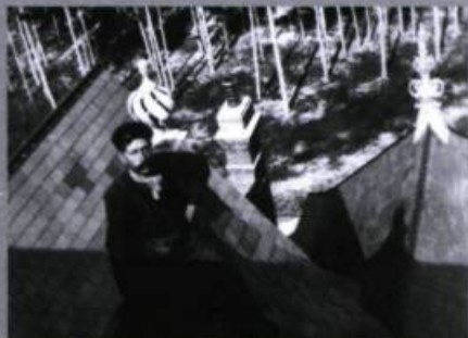
Joseph-Élie Trépanier, plombier-ferblantier, inspectant les ardoises du toit de la villa. À remarquer, le raffinement des cheminées et des têtes de faite. Photo prise vers 1910. (Source : Collection privée)
