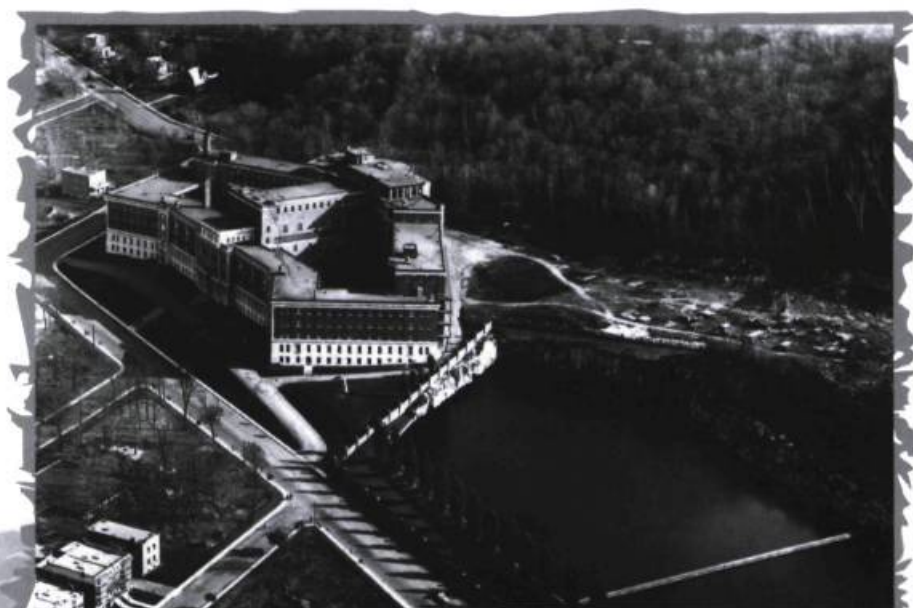
Maison mère de la communauté vers 1930 à côté du réservoir d'eau Bellingham.
