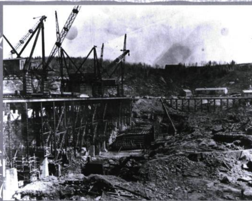
La mise en place des premières turbines.
