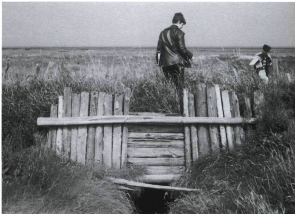
Détail du portique et de la vanne d'un aboiteau Source : Gilles Boileau
