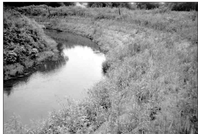
FIGURE 3. Travaux de stabilisation des berges, à l'aide d'un adoucissement de la pente de la berge externe (30°) et de l'ajout de végétation, effectués en juin 2003 au site d'étude (vue vers l'aval).
